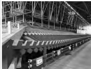
南門建屋内部には制震装置が組み込まれ、地震に対応出来るようハイブリット構造となっていて、現代における復原工事の内容になっていて素晴らしい。
