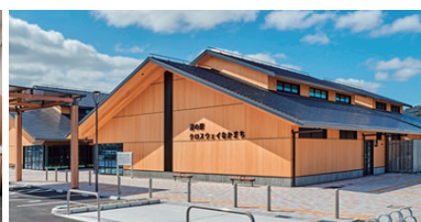
道の駅クロスウェイなかもち (令和6年11月開駅)
